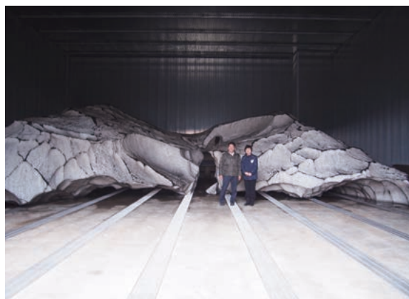
1500 tの雪が入るJA北魚沼の利雪型米穀低温貯蔵施設(写真は平成27年12月現在。この写真に写っている雪は平成27年2月の雪)
