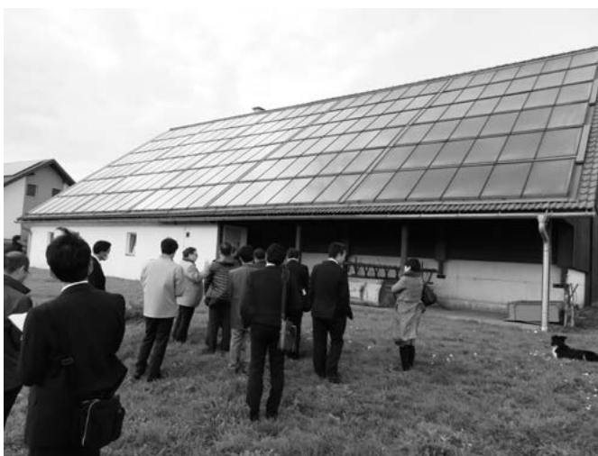
太陽光温水器と木質ボイラーの熱供給施設（ウアバウスドルフ村）
