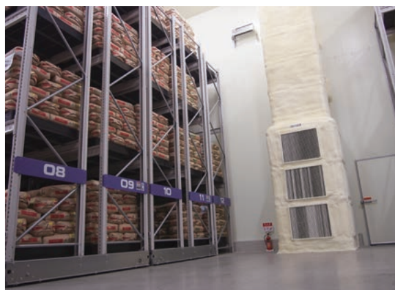
雪の冷風が送られるJA北魚沼の低温貯蔵庫
