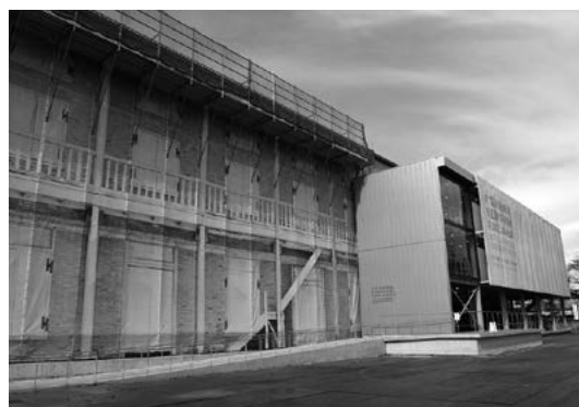
保存修理工事を行っている「西置繭所」外観
