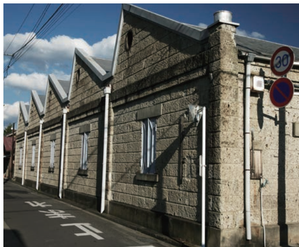
市内に残るノコギリ屋根工場。写真は国登録文化財の旧曾我織物工場(桐生市)
