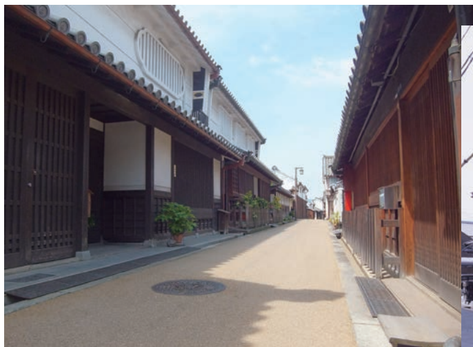
500軒もの伝統的建造物が並ぶ今井町
