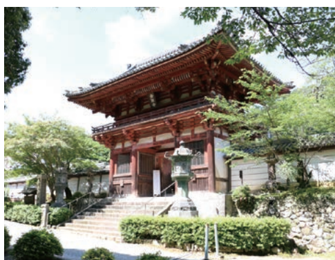
平成21年度から平成大修理が行われている「天野山金剛寺」
