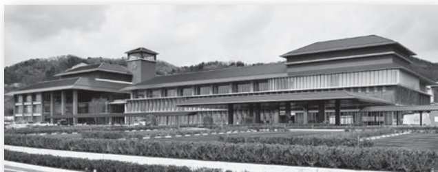
免震構造を有する市役所庁舎と交流防災拠点施設アエルワ(左奥)
