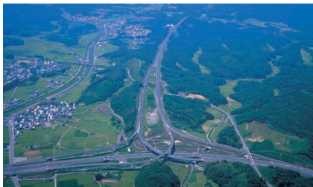
中部圏と近畿圏を結ぶ新名神高速道路亀山JCT周辺
