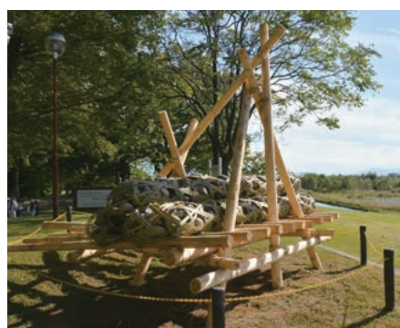
急流に対抗するべく信玄時代に考案された「聖牛」
