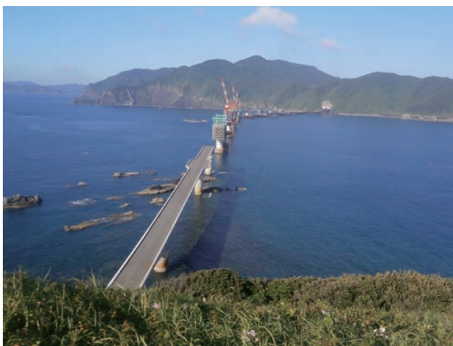
2020年に完成予定の「蘭牟田瀬戸架橋」
