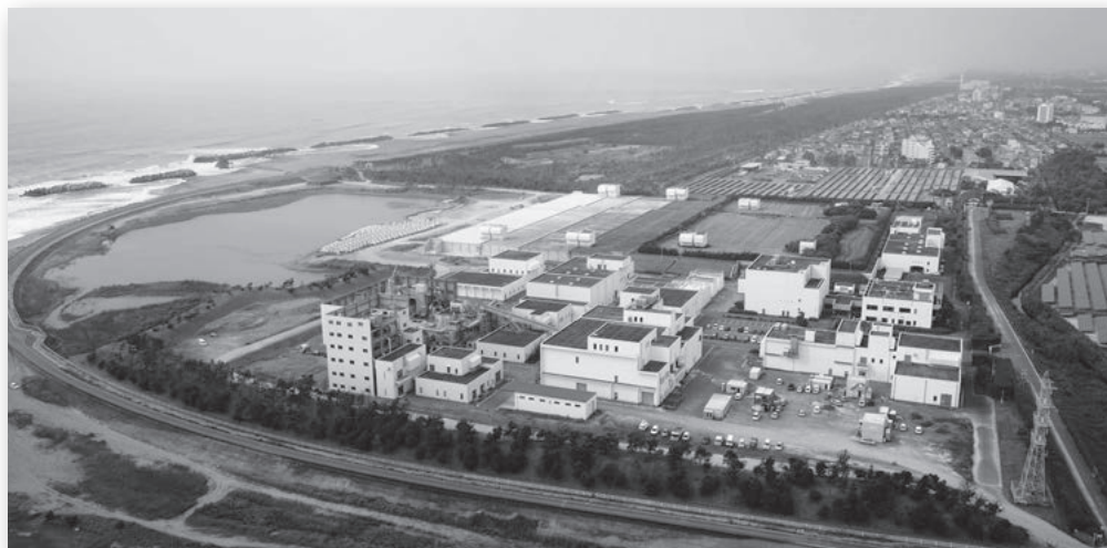
西遠浄化センター 本市最大の終末処理場で処理能力は200,000m 3 /日
