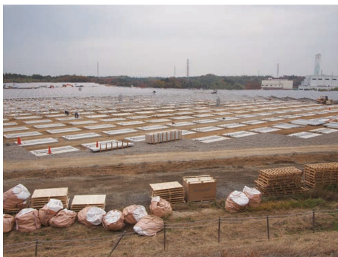
ゴミ処理施設の跡地に建設中のメガソーラー
