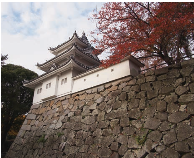
藤堂高虎・築城の津城跡(県史跡)の石垣上に建てられた三重櫓
