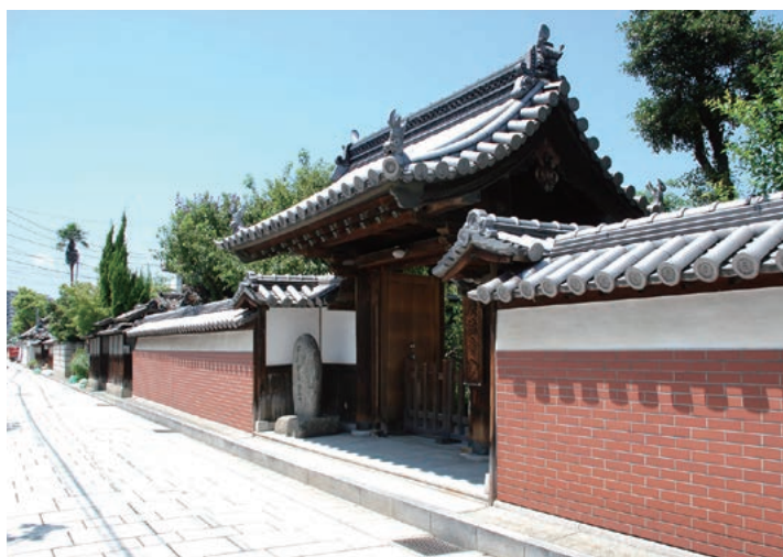
旧尼崎藩時代の町並みが残る寺町
