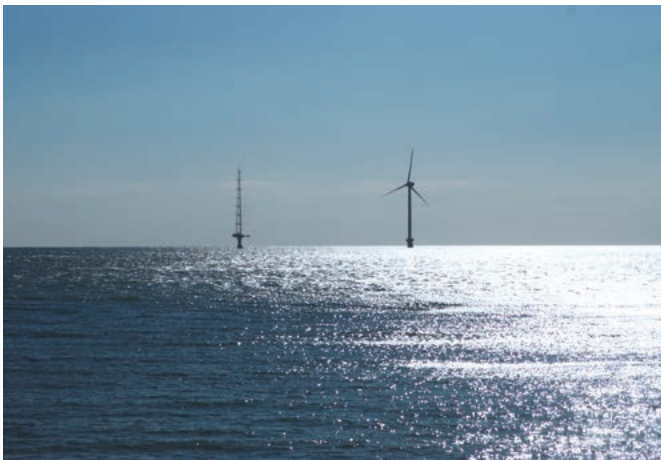
銚子沖の洋上風力発電
