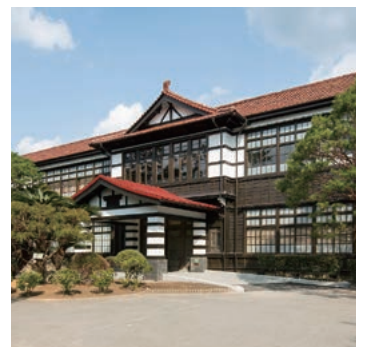
萩藩校跡に建つ日本最大の木造校舎「萩・明倫学舎」
