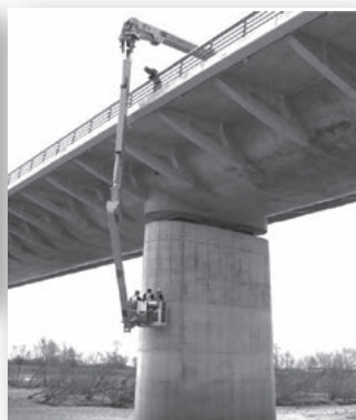
超大型橋梁点検車による近接目視
