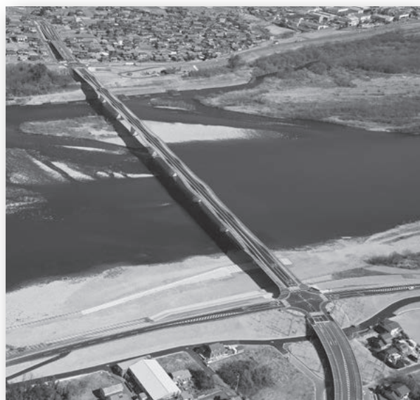
一級河川木曽川に架かる各務原大橋
