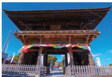
本市に現存する最も古い木造建築物「甚目寺観音南大門」
