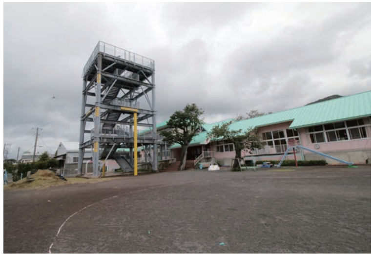
土肥子ども園に造られた高さ16.5mの津波避難タワー
