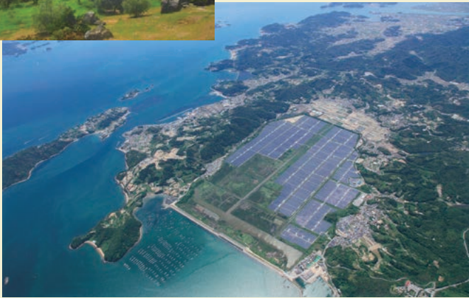
日本最大級のメガソーラーの発電所
