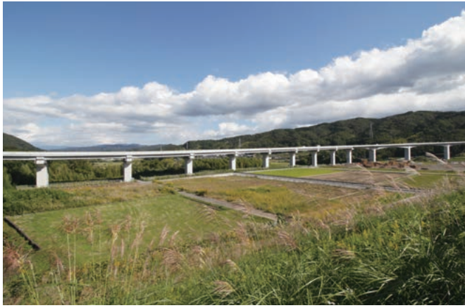
伊豆縦貫道路の一環をなす天城北道路(令和2年12月開通)
