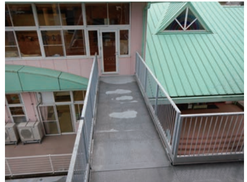
津波避難タワーと園舎は2Fで直接連絡
