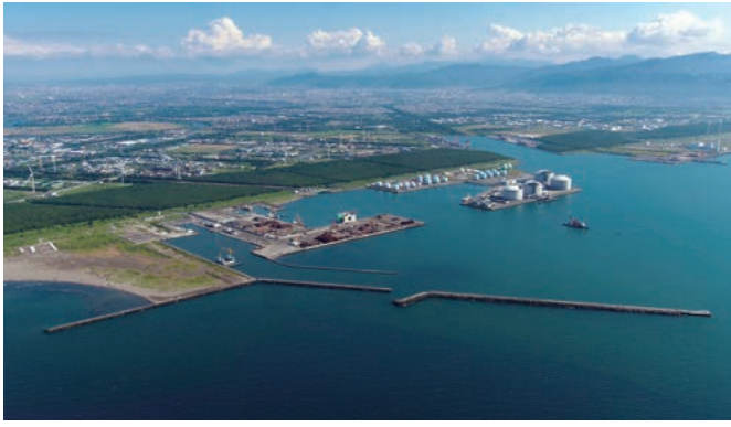
エネルギーの供給拠点としての役割も担う「石狩湾新港」
