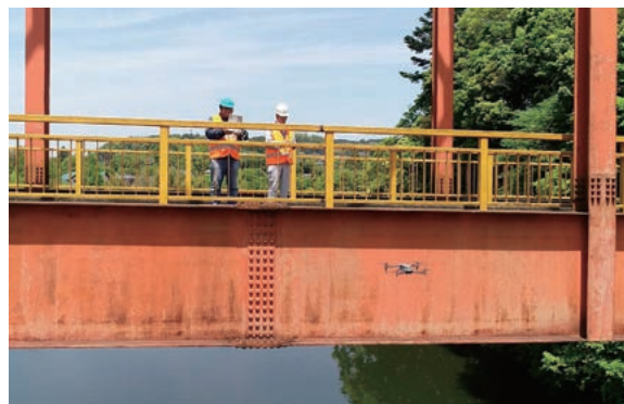
ドローンとAI、ICTを活用した橋梁点検
