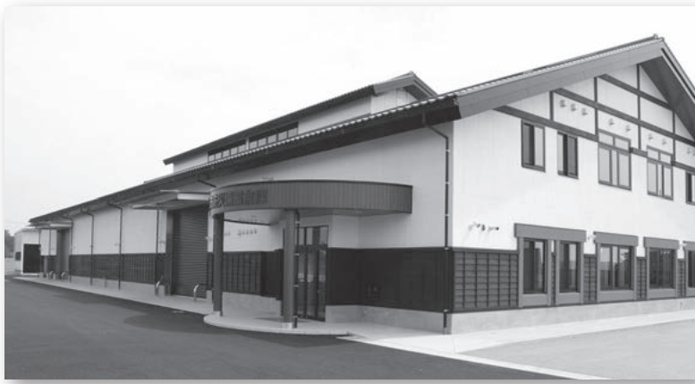
平成25年8月に完成した防災備蓄倉庫「相馬兵糧蔵」
