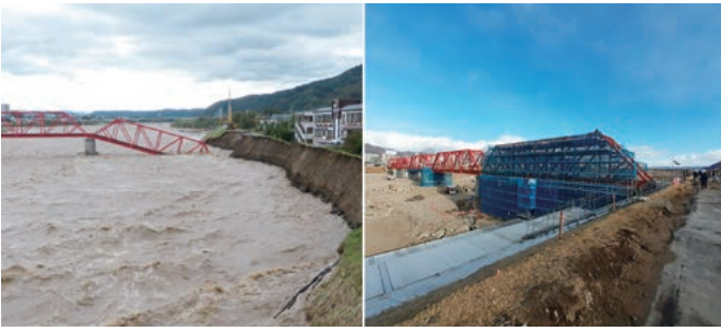
上田電鉄別所線千曲川橋梁（左は被災直後で、右は復旧工事中）
