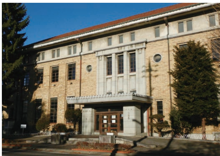
市制施行に合わせて建設された旧岡谷市役所庁舎
