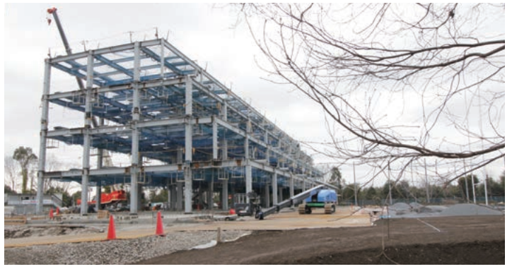
パナソニック ワイルドナイツの本拠地に建設中の宿泊棟(一般も利用可)
