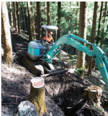
重機を使用して作業する地域おこし協力隊
