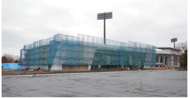
パナソニック ワイルドナイツの活動拠点となるクラブハウスは完成間近
