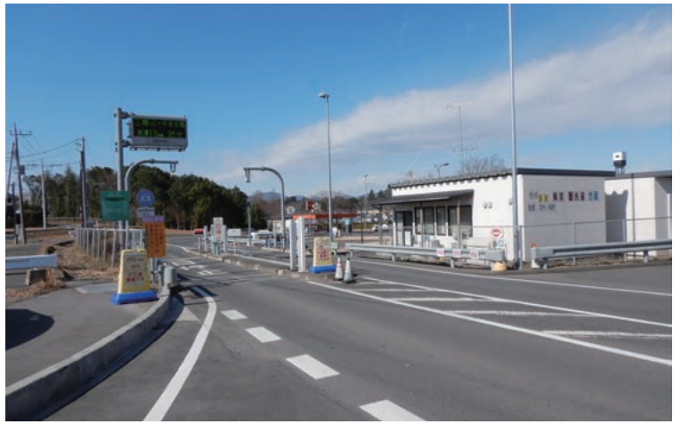
交通の要衝・笠間にはJCTの他に、三つのICとスマートICが存在(友部スマートIC付近)
