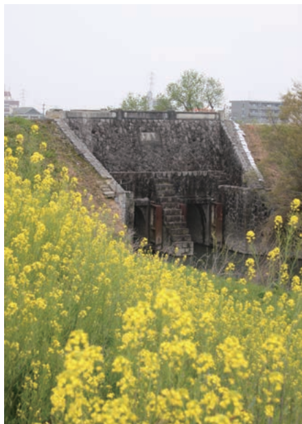
たたぎ工法で造られた五六開門
