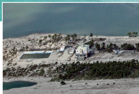
津波直後のサイクル スポーツセンター
