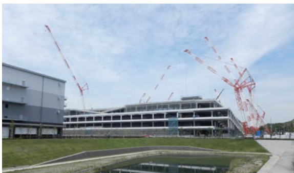
建設中の東洋最大級の物流センター
