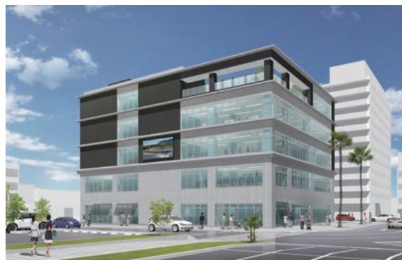
延岡駅西口に整備中の再開発ビルの外観
