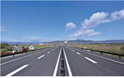
東北中央自動車道（伊達中央ICから伊達桑折IC間）
