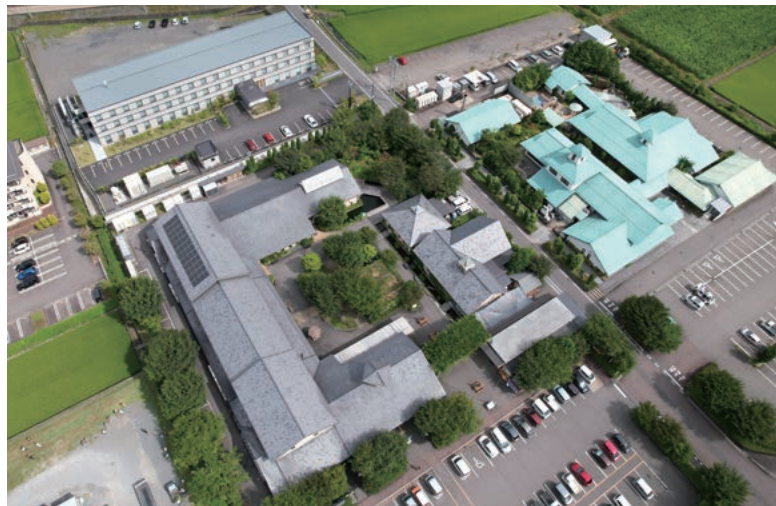
道の駅「古今伝授の里やまと」(左手前)に隣接する、「やまと温泉やすらぎ館」(右手前)、宿泊特化型のホテル「フェアフィールド・バイ・マリオット・岐阜郡上」(左奥)(郡上市)
