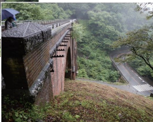
アプトの道のハイライト「めがね橋（国指定重要文化財）」は川底からの高さ31m!!
