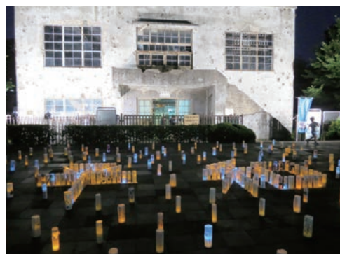
日立航空機変電所の前で8月に開催される「平和市民のつどい」(令和元年開催分)
