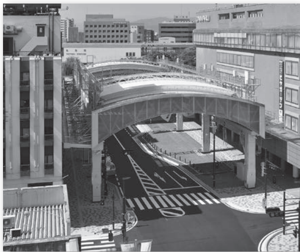
バード・ハット完成(南側から)
