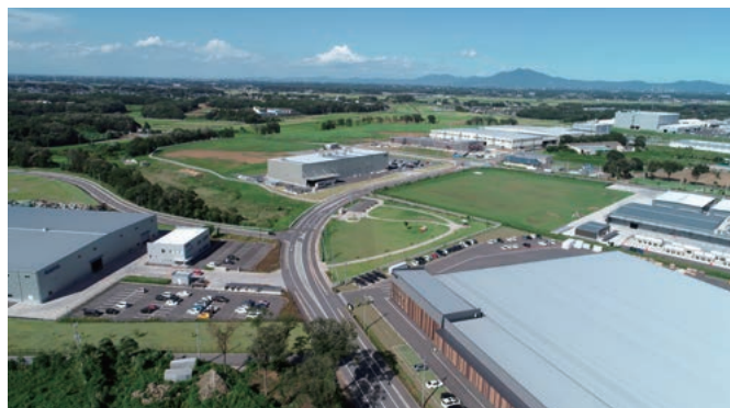
整備が進められている坂東インター工業団地
