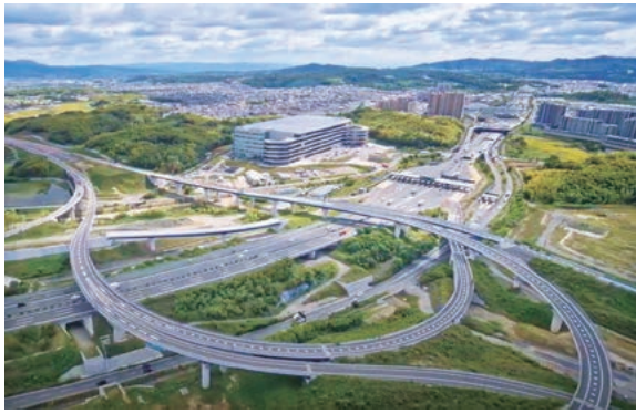
令和5年度に全線開通予定の「新名神高速道路 八幡京田辺JCT+IC」
