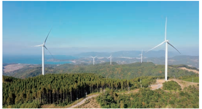
九州最大の風力発電所・串間ウインドヒルは脱炭素社会構築の推進源
