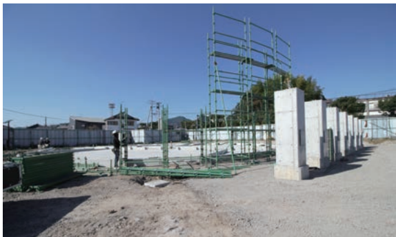
「道の駅くしま」の背後地で建設が進む「市民交流施設」
