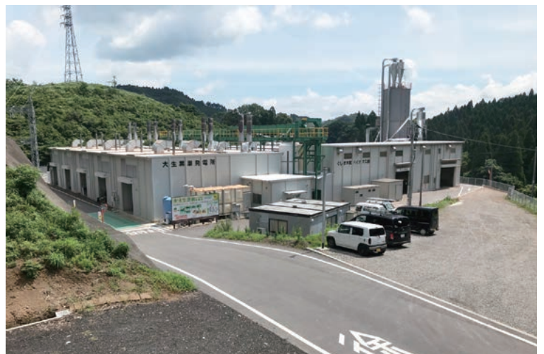
杉の間伐材など木質バイオマスをフル活用するバイオマス発電所
