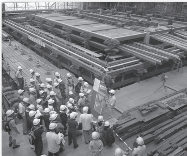
宝城坊本堂の修理現場で実施した見学会
