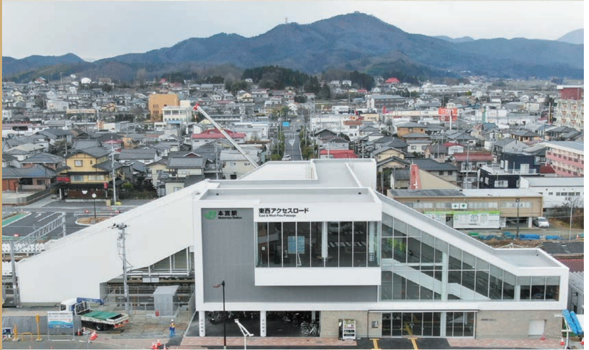
令和3年12月に完成した本宮駅東西自由通路と駅舎
