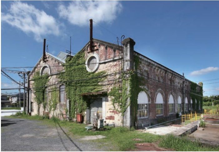
遠賀川水源地ポンプ室（写真提供：日本製鉄㈱九州製鉄所）
