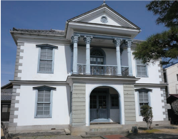
近代の本庄の威勢を示すコリント式西洋建築の旧本庄警察署（明治16年築）
