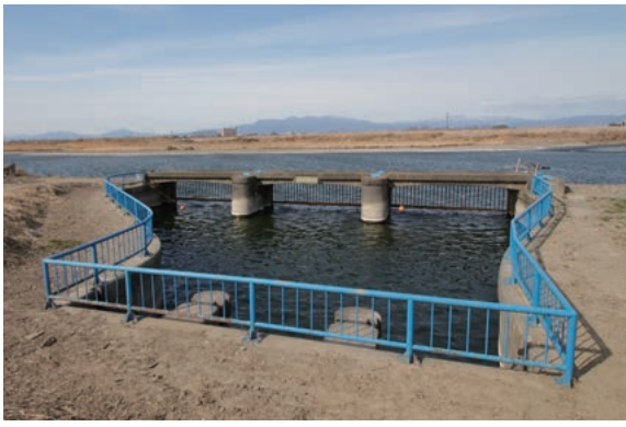
本庄市の取水口から始まる「世界かんがい施設遺産・備前渠水路（本庄市・深谷市・熊谷市を貫流）」は利根川の水利のシンボル
