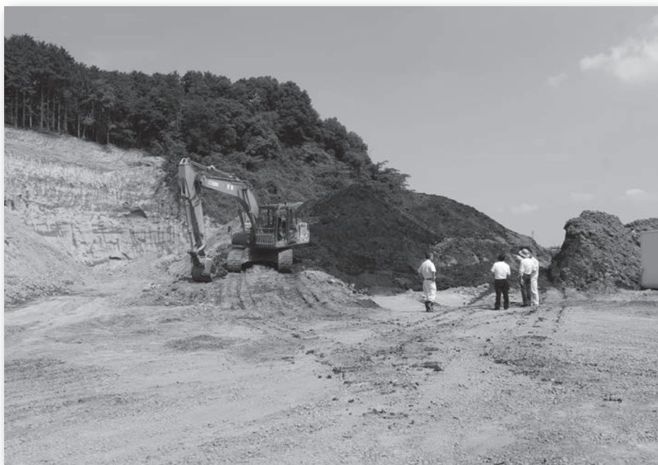
小場地内の現場
