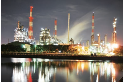
臨海部コンビナートの工場夜景
