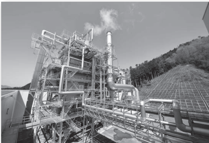
バイオマス発電所
