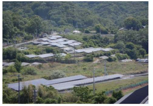
日照量の豊富な阿波市では随所に太陽光発電施設が立地(アエルワ展望室からの撮影)
