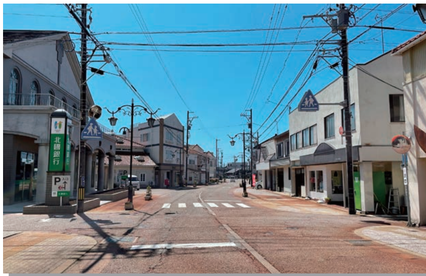
道路は12mに拡幅され、歩道も整備
