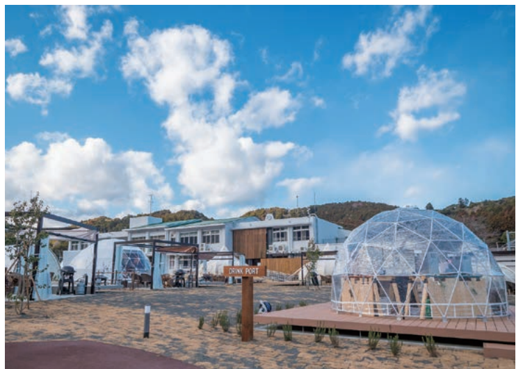
旧小学校を活用して整備されたグランピング施設「Glamping & Port結」(島田市)
