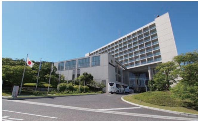
「夢舞台」に立地する国際コンベンション施設兼ホテル《グランドニッコー淡路》
