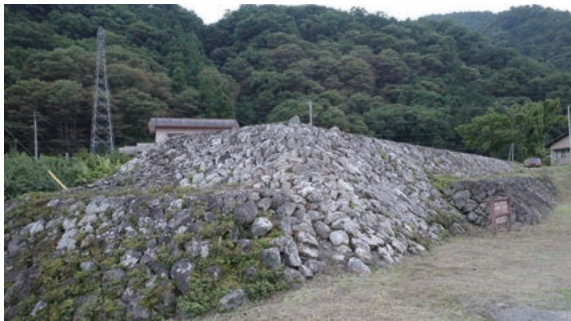
暴れ川・御勅使川の治水の要、日本に3件しかない国史跡指定・河川堤防の一つ「御勅使川旧堤防(将根頭・石横出/しょうぎがしら・いしつみだし)」
