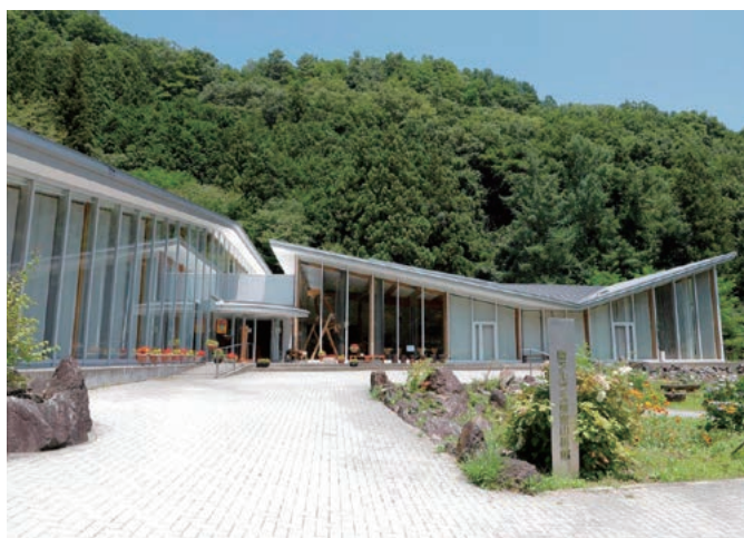
南アルプスユネスコエコパークの入り口として機能する「エコパーク管理事務所」（芦安地区）
