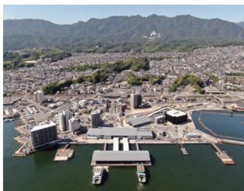
宮島口ターミナル（工事中）
