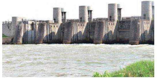
大河津分水には二つの堰(写真左・大河津可動堰、写真右・大河津洗堰)があり、水量調節を随時行う
