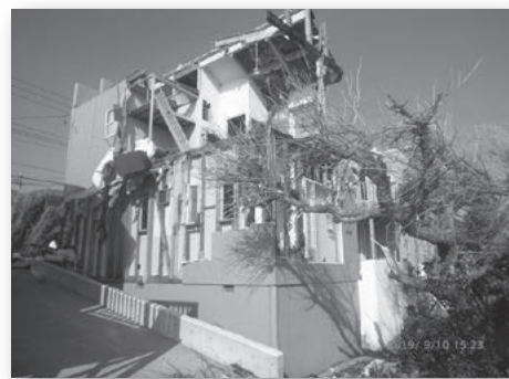
令和元年台風被害(住家損壊)
