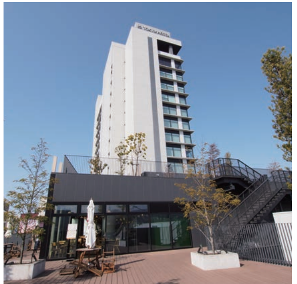
三島駅南口再開発事業の一環として建設された富士山三島東急ホテル
