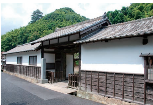
銀山街道の起点、大森代官所跡。代官所周辺には、多くの役所関連遺構が残る。かつては代官所から瀬戸内海まで3泊4日の行程で銀が輸送されていた
