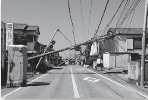
令和元年台風被害(電柱倒壊)
