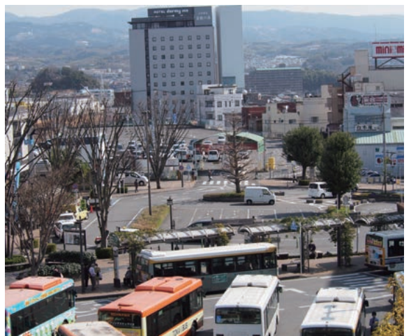
三島駅南口周辺再開発事業でビルディング4棟が建設予定の「三島駅南口東街区A地区」(バスターミナルの向こう側)
