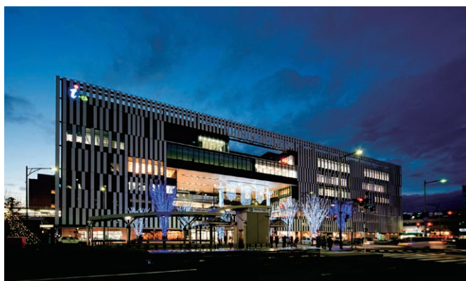
尾張一宮駅前ビル「i-ビル」内には、市立中央図書館、中央子育て支援センター、市民活動支援センターなどの公的施設が数多く入居
