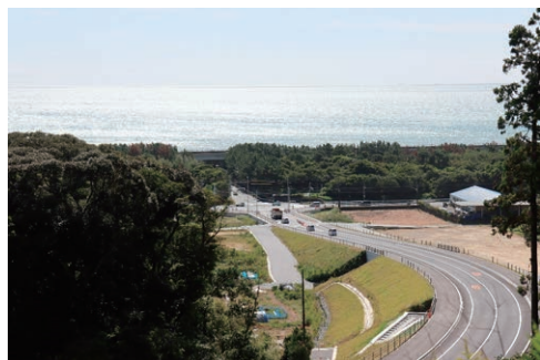
開通した幹線道路 (通称:バッテリーロード)
