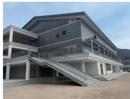
新たに整備した呉市立天応学園体育館棟
