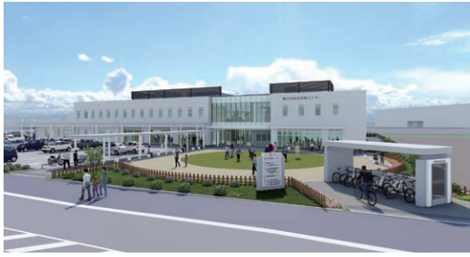
総合保健センター（仮称）外観イメージ
