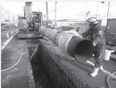
耐震管への入れ替え
